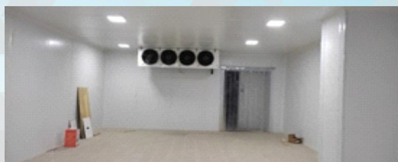
Şoklama kamerası müxtəlif növ məhsulların uzunmüddətli saxlanması təmin etmək üçün  $-35^{\circ}\text{C}/-45^{\circ}\text{C}$  temperaturda sürətli və effektiv dondurulmasını təmin edir. Dondurulacaq (şoklanacaq) məhsul tipologiyasından asılı olaraq 12-24 saat ərzində kamerada dondurulur. Həmin məhsullar daha sonra  $-5^{\circ}\text{C}/-25^{\circ}\text{C}$  temperatur intervalında təmin edilmiş soyuducu anbarlarda saxlanması müddətinə müvafiq olaraq saxlanılır.
